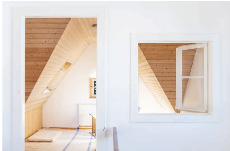
Der Innenausbau der Räume ist im vollen Gange.
