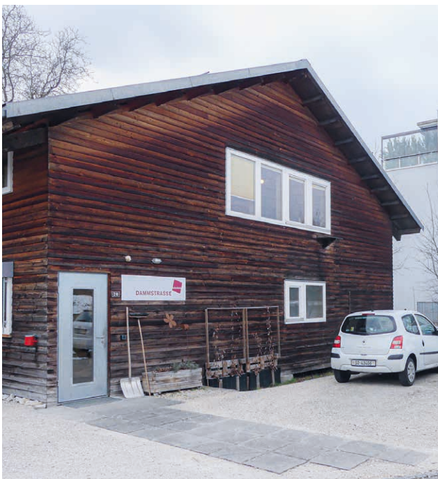
An der Dammstrasse wird viel mit Holz gearbeitet.
