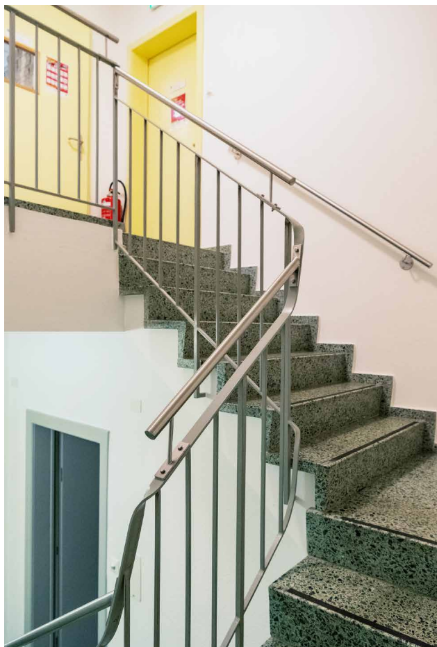
Der Arbeits- und Wohnraum im Haus 108 wurde durch die Sanierung und Renovation merklich aufgewertet.
